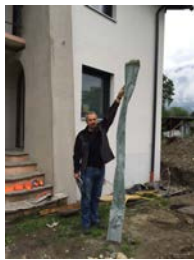
Provisorische Dachrinne, welche beim Unwetter versagte
